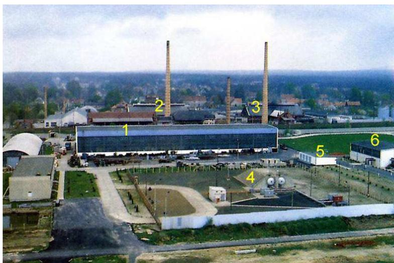
Abb. 26 Bildausschnitt Betriebsgelände VEB Glaswerk Schwepnitz, 1 CV-Halle, 2 Hüttengebäude für Becherproduktion, 3 Hüttengebäude Pressglas, 4 Propangaslager, 5 Trafostation, 6 Medienhalle
