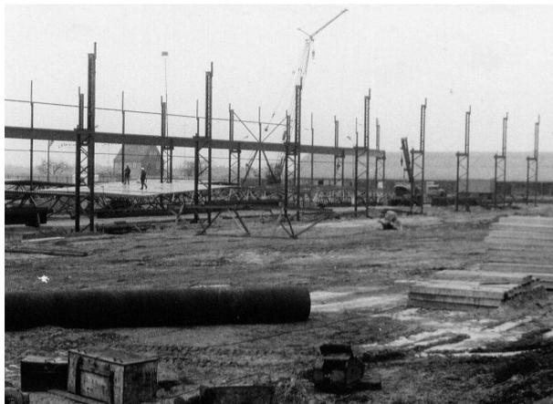
Abb. 25a: Montage der Halle zur Produktion von chemisch verfestigtem Glas
