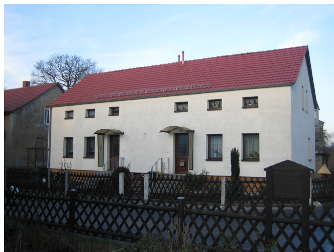
„Am Glaswerk 29/30“, rekonstruiertes Glasmacherhaus (Es ist das einzige Gebäude der ehemaligen Glasfabrik, dass unter Denkmalschutz steht.)
