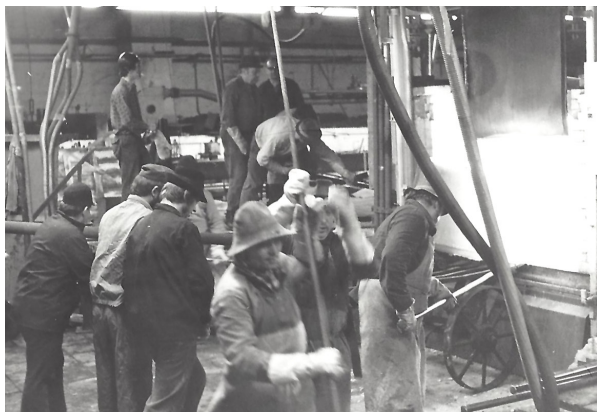
Fast erschreckende Bilder beim Hafenschmelzen; die dafür vorgesehene Technologie zwang die Beteiligten bis an die Grenze ihrer Kräfte (Ofen II, „Bärenhütte“, 1977)
