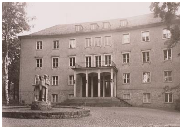
Ingenieurschule für Glastechnik
